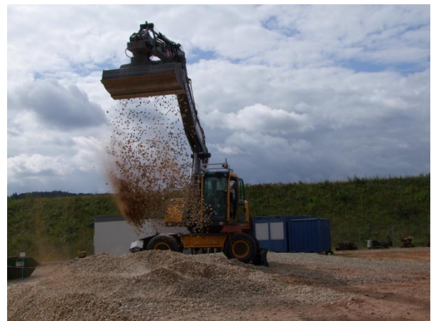
Abbildung 1: Der reale Volvo EW180B bei der autonomen Ausführung eines Grabvorgangs
